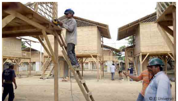
Viviendas mejoradas construidas con materiales locales.
