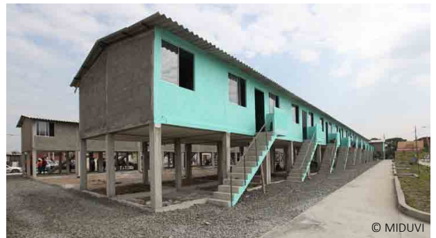
Viviendas sociales del gobierno elevadas sobre estructura de hormigón armado.
