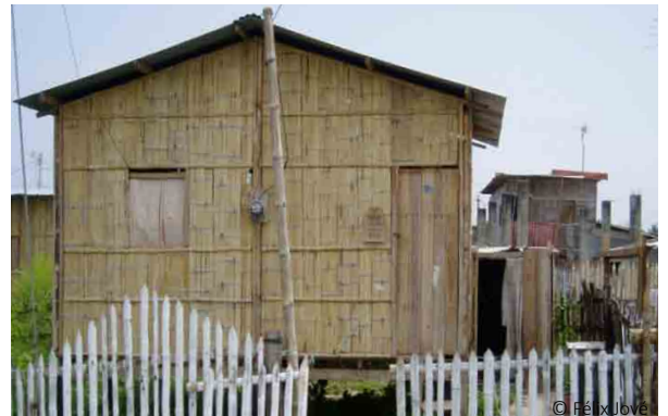
Vivienda nueva construida en base a un modelo vernáculo con cambio de los materiales de cubierta.
