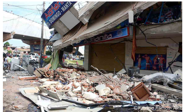
Inmueble colapsado tras terremoto en Manta.
