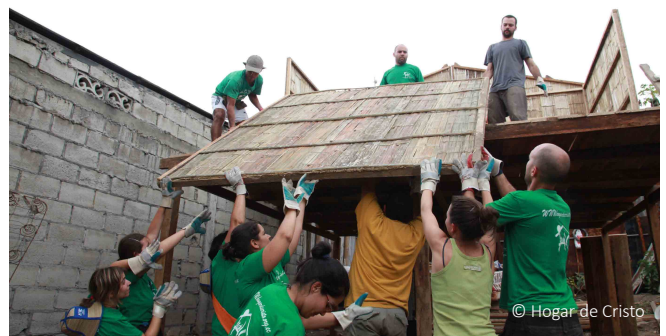
Armar una casa es muy rápido gracias al sistema de paneles prefabricados de caña picada con estructura de madera.
