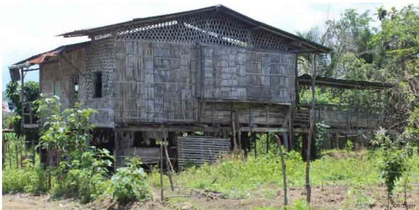
Vivienda vernácula con diversos mecanismos para mejorar la eficiencia bioclimática.
