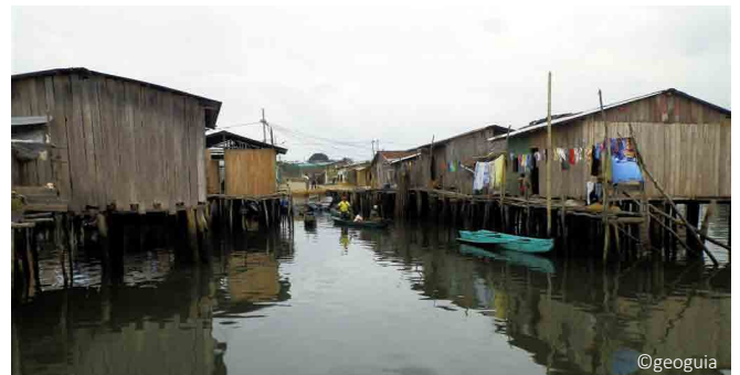
Las viviendas elevadas están protegidas de las inundaciones, en ocasiones directamente construidas sobre estuarios.
