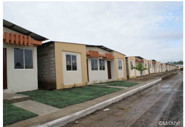
Viviendas del MIDUVI en Manta, sin consideración de los factores climáticos y culturales.
