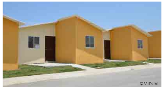
Viviendas del MIDUVI en Manta, con un factor de forma negativo de cara a la resistencia frente a los terremotos.
