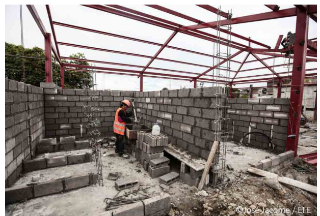
Reconstrucción de mercado en Pedernales tras terremoto.
